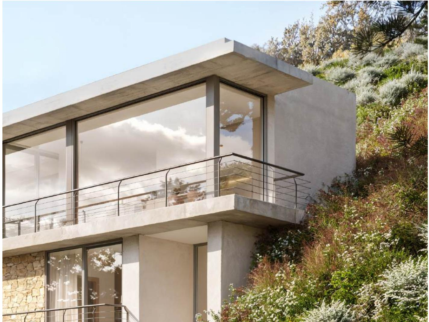
Cerramientos de aluminio marca Cortizo Cor Vision con guía oculta en la zona del comedor o similar, con doble vidrio en balconeras y ventanas.
