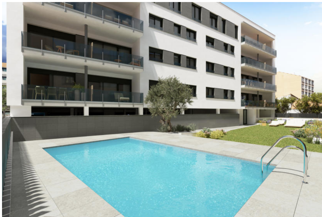
Piscine communautaire. Détecteurs de mouvement LED dans les cages d'escalier et les entrées. Murs enduits et peints, et faux plafond en plaques de plâtre.
